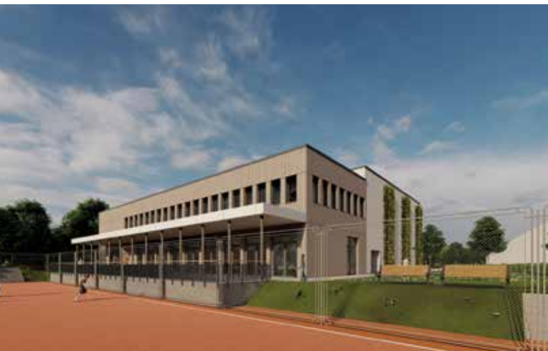
Seitenansicht vom Tennisplatz auf die zukünftige Terrasse und das neue Gebäude.
