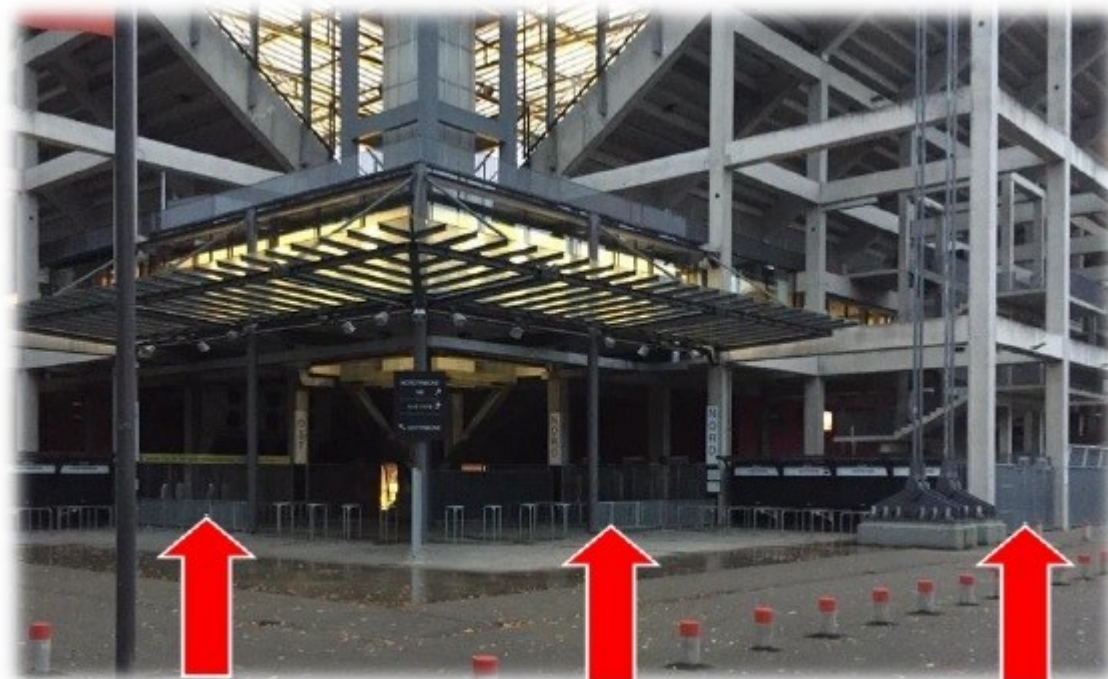
Eingang Block O11
